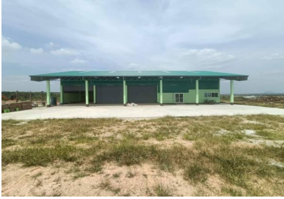
อาคารรวบรวมผลผลิตที่สร้างในพื้นที่ คทช.
